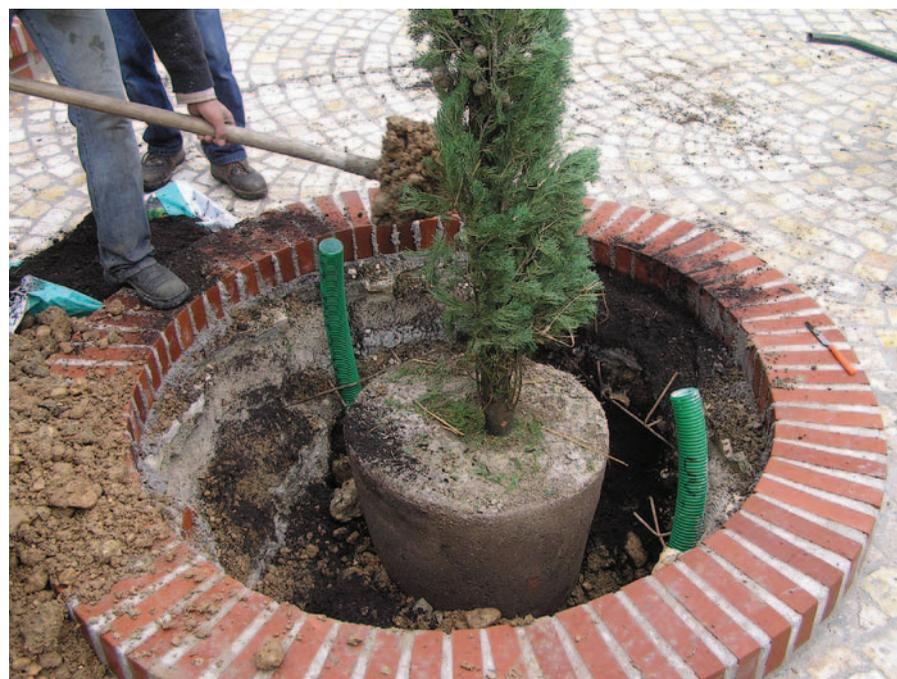
**Figg. 19 e 20 - Posizionamento del tubo drenante sotto il pane di terra della pianta.**
