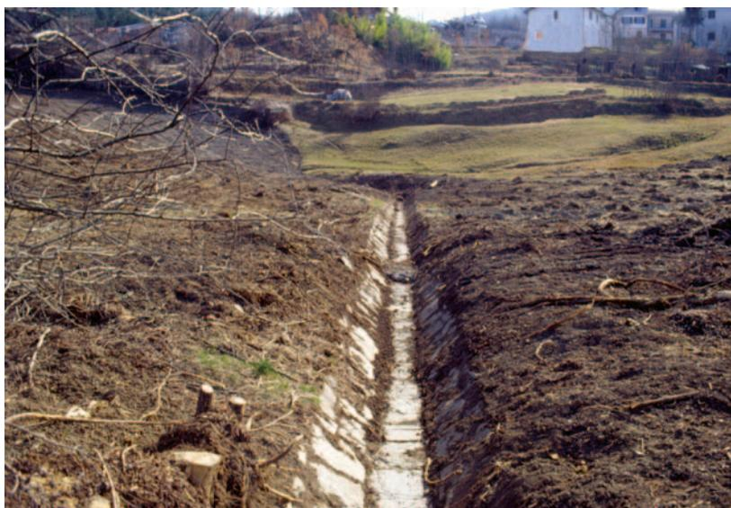
Fig. 5 - Recupero funzionale di un piccolo fosso di scolo delle acque.
